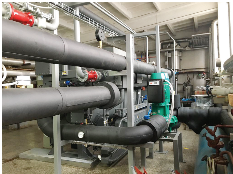
Rys. 1. Instalacja bromolitowego agregatu adsorpcyjnego zasilanego parą
