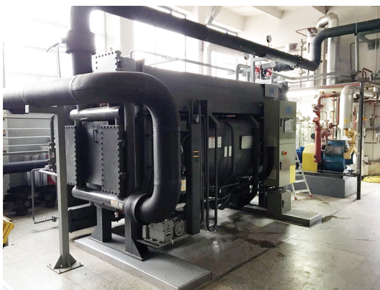
Rys. 4. Dwustopniowa i dwuefektowa Bromolitowa chłodziarka absorpcyjna SL Eco-Energy Systems zabudowana przez New Energy Transfer w istniejącą amoniakalną instalację chłodniczą
