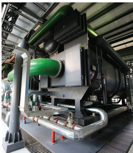
Rys. 6. Absorpcyjna pompa ciepła SL Eco Energy Systems o mocy 30 MW zasilana parą, pracująca na potrzeby sieci ciepłowniczej
