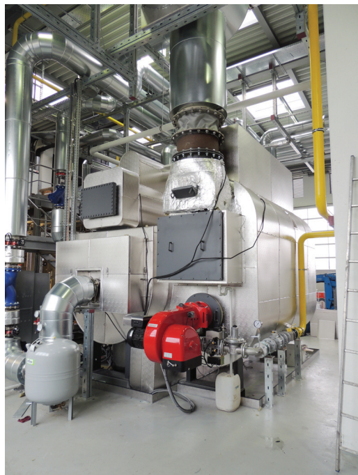
Rys. 4. Absorpcyjna pompa ciepła SL Eco Energy Systems o mocy 5 MW w wbudowanym palniku gazowym zabudowana w ciepłowni geotermalnej
